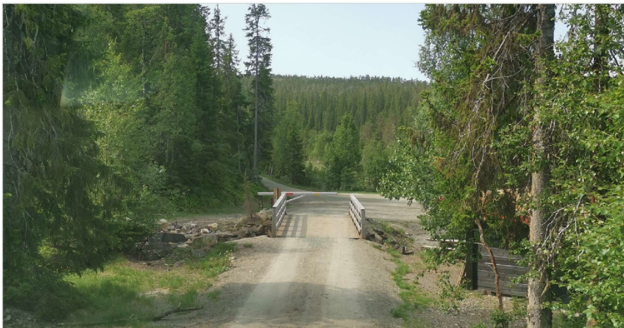
Figur 3-3 Bom ved Rangå, sett mot nord. Bommen stenger av landbruksvegen (juni 2020)
