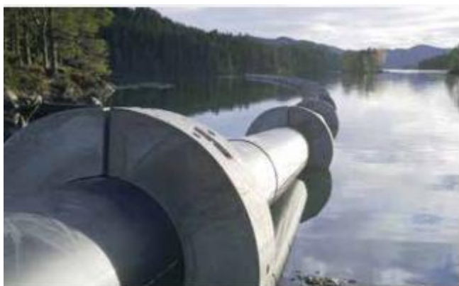
Inntaksledning i Benna.
