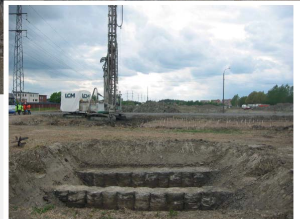
Figur 1.1.2 Kalksmentepelrigg som installerer kalksmentpeler. I forgrunnen installerte kalksmentpeler satt i ribbemønster.
