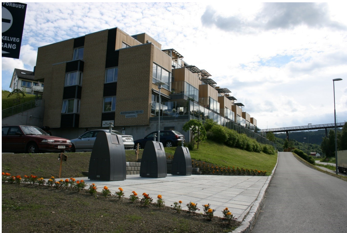
Figur 11: Eksempel på nedgravd containerløsning. Foto: Trondheim Renholdsverk
